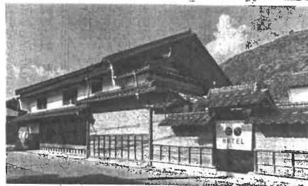
ホテルなどが入ったNOTEの複合施設(兵庫県朝来市)
