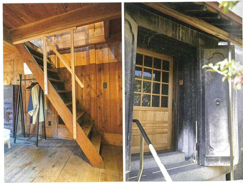
[右] 分厚い蔵の扉の中に、新しい扉を設置。[左] 昔ながらの急な階段。登るのが少々大変だが、昔ながらの暮らしを体感するにはうってつけ
